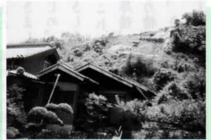
土砂崩れした民家の裏山
